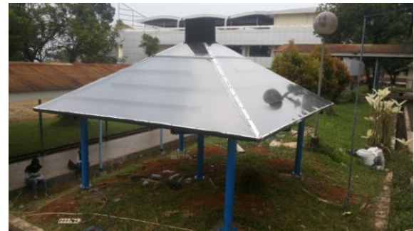
Gambar 6. Model atap rumah kolektor pelat datar (Rosa dkk., 2012)
