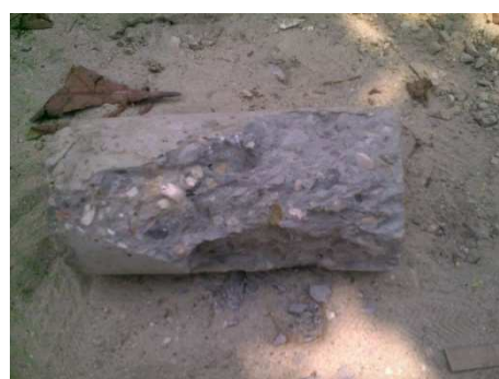
Gambar 3 beton dengan abu insinerator 25%
